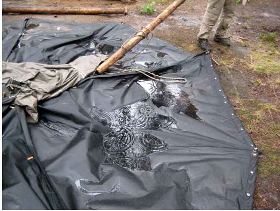
Die „swimming-pools“ werden trockengelegt
